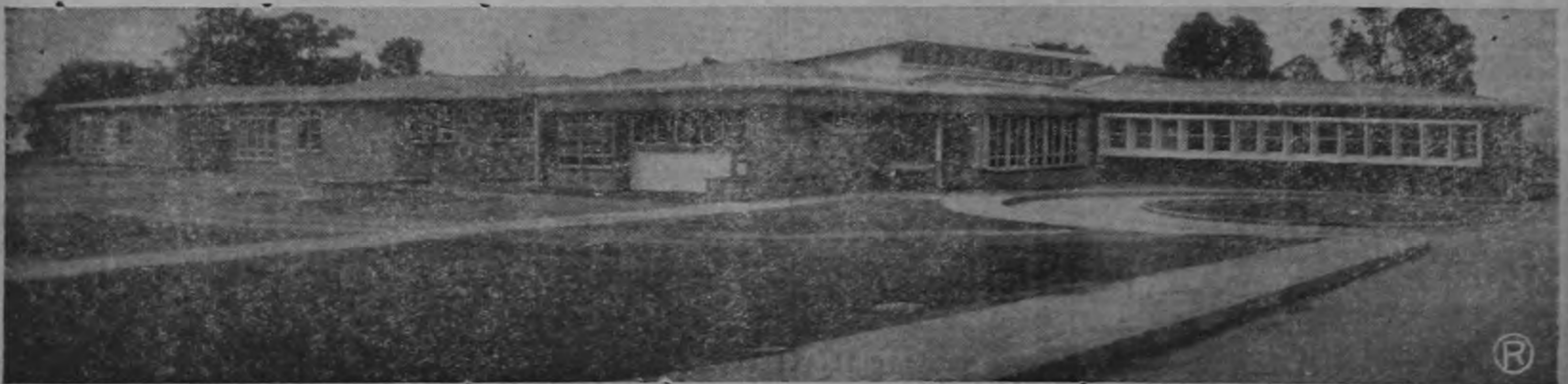
M.O.P. CONSTRUYE HOSPITALES.— HOSPITAL DE GRECIA.— Construido dentro del Plan Hospitalario Nacional elaborado entre el Ministerio de Salubridad y el MOP, con una área de 2670.50 metros. La construcción, consta de ocho Pabellones: Administración, Consulta externa, Suite Quirúrgico-Obstétrico, Medicina General: Mujeres, Maternidad y Pensionado, Medicina y Cirugía General: Hombres, Pediatría, Sección de Servicios. Este edificio se inaugurará próximamente.
